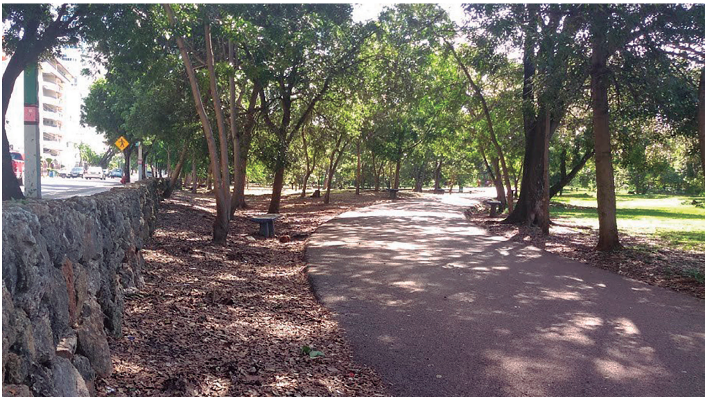
Figura 2. Pared que bordea la acera norte del parque Mirador Sur. Nótese la hojarasca acumulada.
